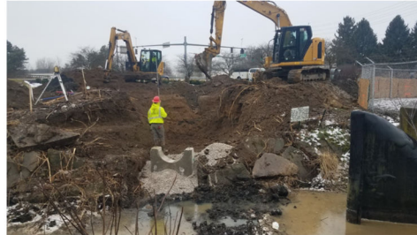
S. Bever St Sewer Separation
